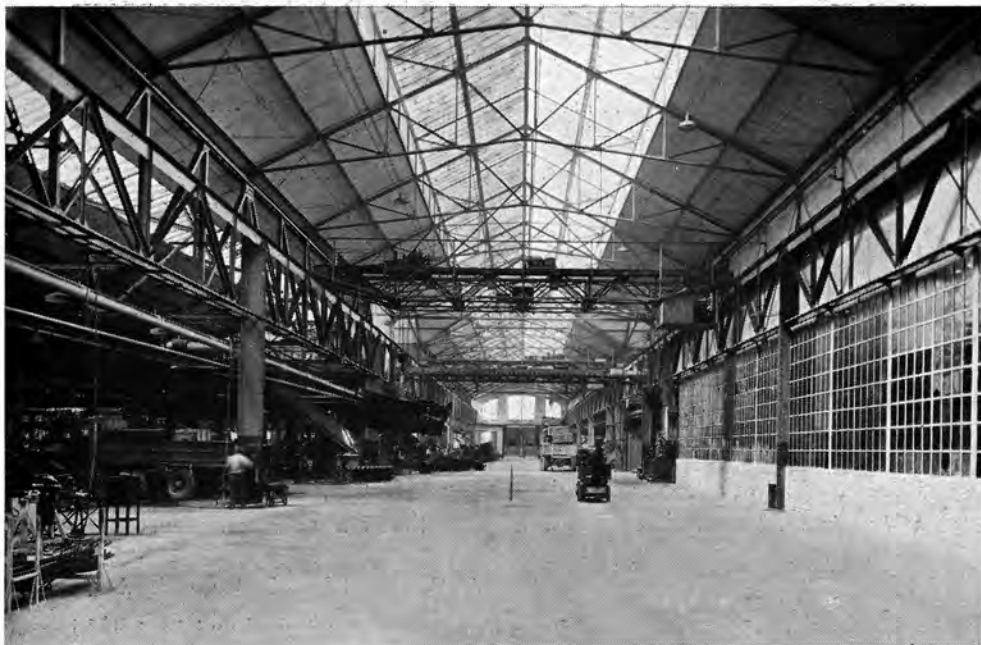
Usine de Mécanique Hall de manutention
