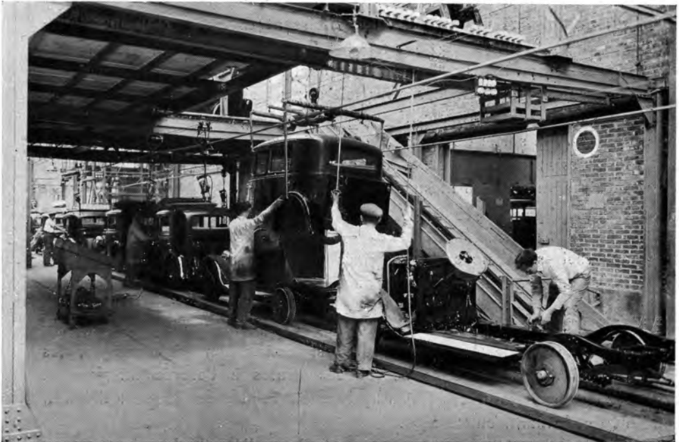
Carrosserie Montage d'une caisse sur le châssis
