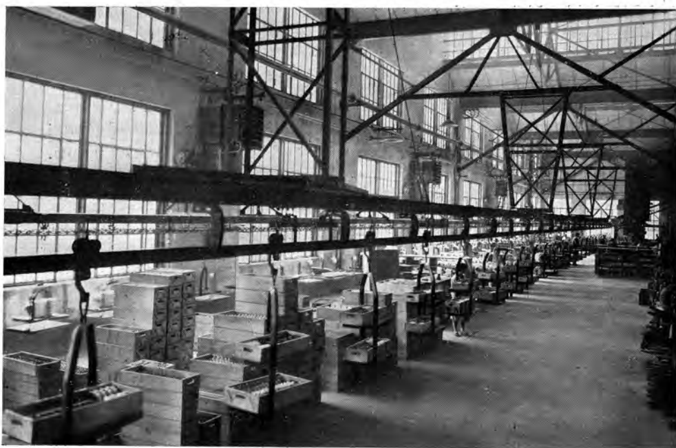
Fonderie Transporteur des noyaux
