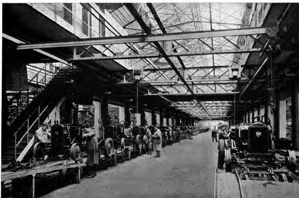
Usine de Mécanique Les deux chaînes de montage de châssis
