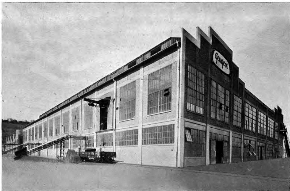
Fonderie Vue extérieure
