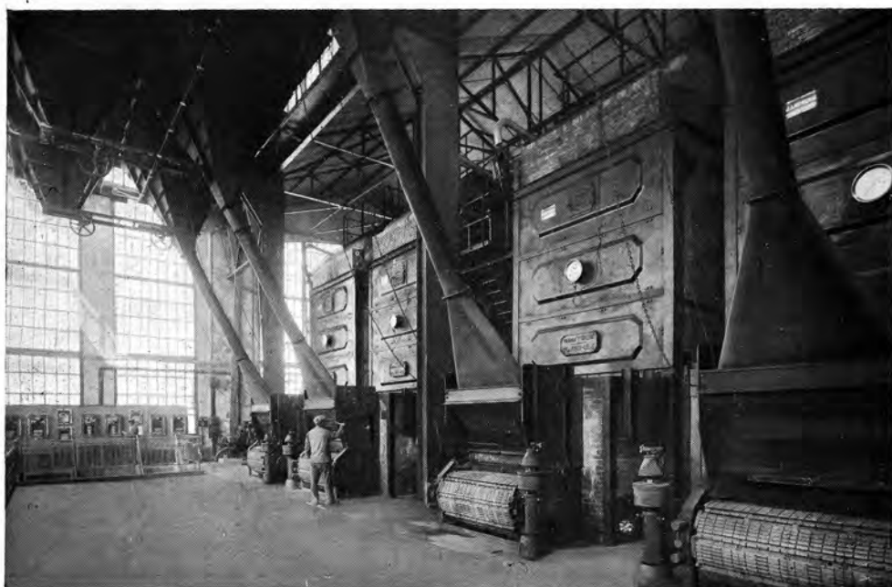
Chaudière de chauffage Une des trois stations
